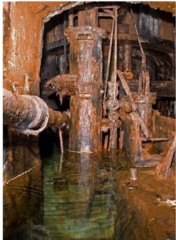
Abbildung 42: *Brendel'sche Wassersäulenmaschine im Mendenschacht [F.: Kugler, J.; 2009]*
