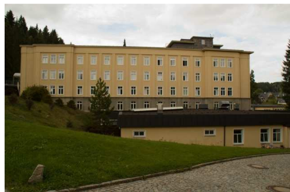
Abbildung 5: Südliches Funktionsgebäude und neuer Anbau am Zentralgebäude [F.: J. Kugler 2012]
