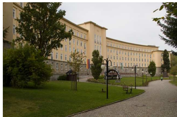
Abbildung 4: Zentralgebäude des Krankenhauses Erlabrunn [F.: J. Kugler 2012]
