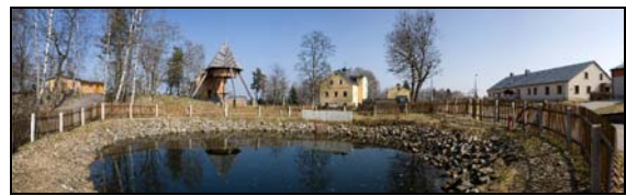
Abbildung 44: Gesamtansicht der Tagesanlagen am Rudolph Schacht (v.l.n.r. Bergschmiede, Pferdegöpel, Huthaus, Sanitärtrakt und Lampenhaus)
