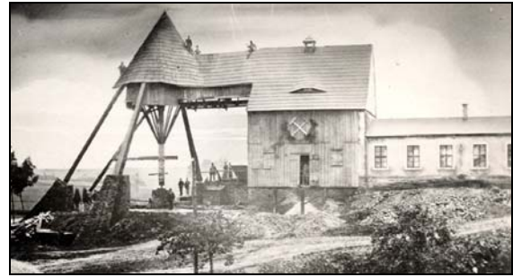
Abbildung 48: Historische Ansicht des Pferdegöpels auf dem Rudolph Schacht (1877 um) 13 [v.l.n.r.: Rennbahn, Treibehaus, Scheidebank]
