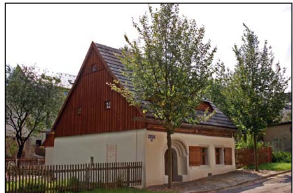
Abbildung 34: Das Lindenhäuschen nach der Sanierung mit neu gepflanzten Linden.
