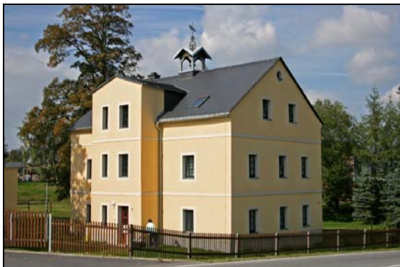
Abbildung 47: Hut- und Verwaltungshaus am Rudolph Schacht
