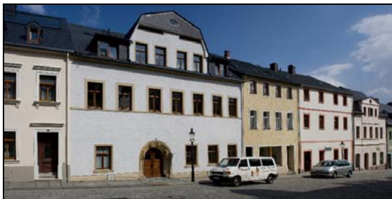
Abbildung 31: Die Bürgerhäuser Zschopauer Straße 20, 18 und 16
