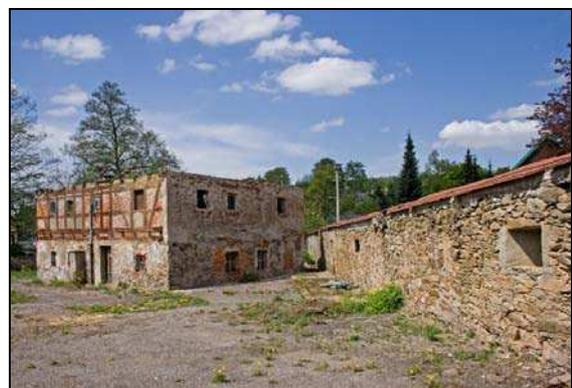
Abbildung 13: Hüttenmauer und Hüttenschmiede nach dem Abtrag des Dachstuhles und der Giebel
