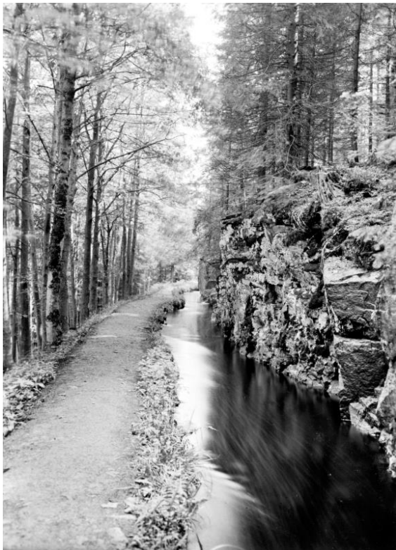
Abbildung 1: Historische Ansicht des Grünen Grabens [F.: P. Schulz, 1928]
