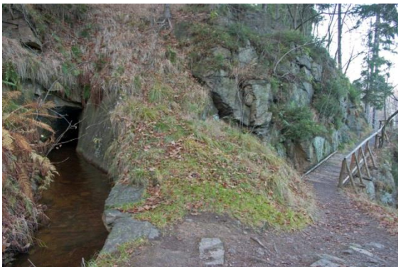
Abbildung 4: Röschendurchführung am Grünen Graben [F.: J. Kugler, 2005]
