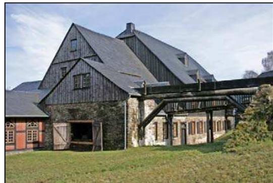
Abbildung 23: Das Siebenschleherer Pochwerk mit Aufschlagfluter zur Radstube des Pochwerks [Kugler, Jens 2007]
