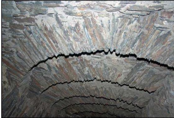
Abbildung 66: Mit überspringenden Bögen mit Bruchsteinen ausgemauerter Schacht [Kugler, Jens 2005]
