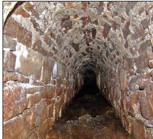
Abbildung 59: Gemauerter Teil der Teichrösche mit Blick zur Wasserseite [Kugler, Jens 2006]
