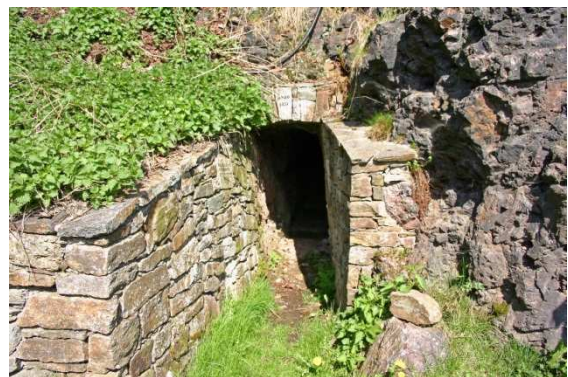
Abbildung 26: Mundloch des Unteren Roten Felsenstollns. [F.: J. Kugler, 2005]
