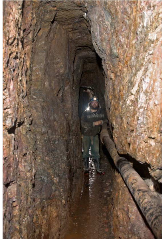
Abbildung 8: Flügel im Markus Semmler Stolln mit der Wasserleitung für das ehemalige „Radiumbad“. [F.: J. Kugler, 2005]
