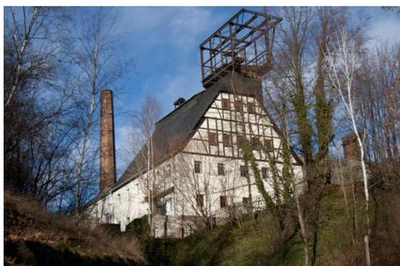
Abbildung 85: Der Giebel des Wassergöpeltriebhauses mit dem aufsitzenden Seilscheibenstuhl aus der letzten Betriebsperiode. [F.: J. Kugler, 2006]
