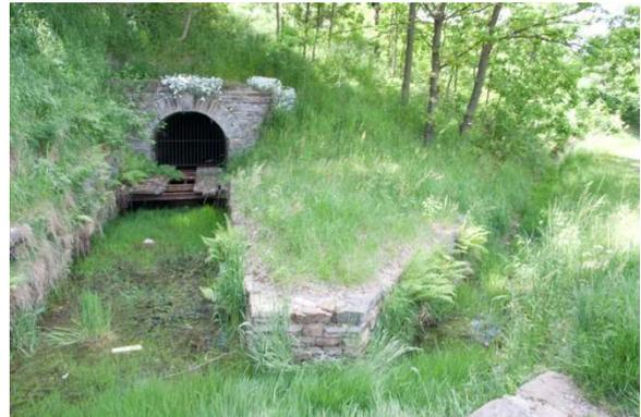
Abbildung 102: Mundloch der Rösche am Roten Graben. [F.: J. Kugler; 2005]
