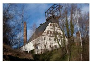
Abbildung 85: Der Giebel des Wassergöpeltreibehauses mit dem aufsitzenden Seilscheibenstuhl aus der letzten Betriebsperiode.
