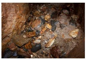
Abbildung 6: Muldenschotter in untertägigen Grubenbauen als Zeugnis von Wassereinbrüchen. [F.: J. Kugler, 2010]
