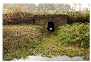
Abbildung 101: Mundloch der Aufschlagrösche vom Hoffnung Schacht der Grube Oberes Neues Geschrei am Roten Graben. [F.: J. Kugler; 2009]
