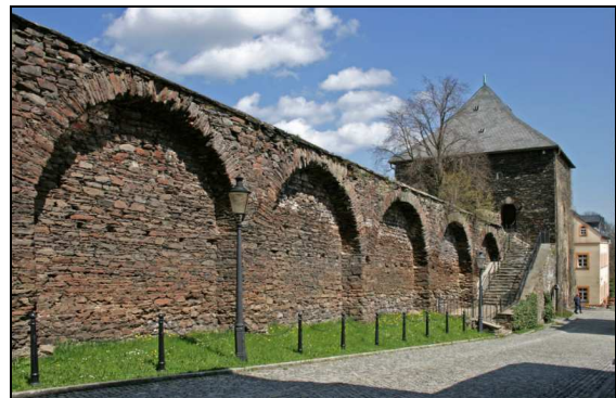
Abbildung 10: Stadtmauer mit Zschopauer Tor
