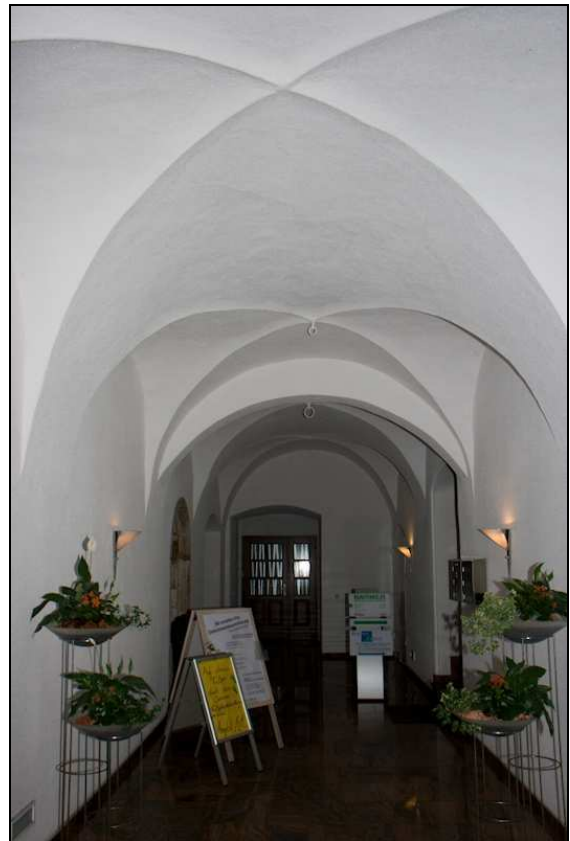
Abbildung 33: Gewölbter Flur im Bürgerhaus
