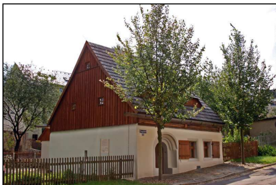
Abbildung 31: Das Lindenhäuschen nach der Sanierung mit neu gepflanzten Linden.
