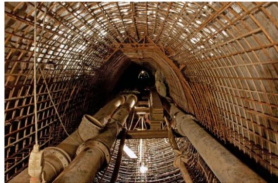
Abbildung 7: Sanierung des Rothschönberger Stollns im Bereich des Schluchtengewölbes [F.: J. Kugler, 2009]
