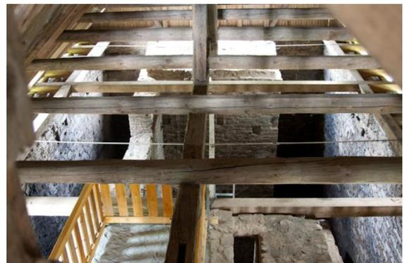
*Abbildung 35: Die beiden unter der Radstubenkaue befindlichen Radstuben von IV. Lichtloch des Rothschnberger Stollns. Links befindet sich die Kunstradstube, rechts die Kehrradstube. [F.: J. Kugler, 2004]*
