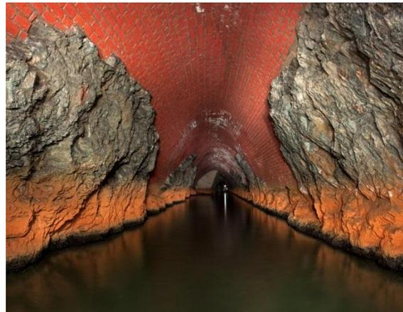
*Abbildung 9: Sicherung des Rothschnöberger Stollns im Bereich des Mundloches durch Klinker- und Sandsteinausbau. [F.: J. Kugler, 2009]*
