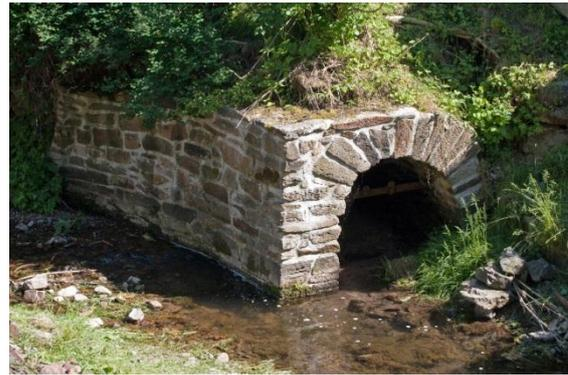
Abbildung 37: Das Mundloch der unteren Abzugsrösche vom IV. Lichtloch des Rothschnberger Stollns [F.: J. Kugler, 2006]
