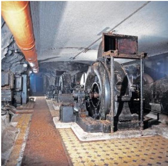
Abbildung 6: Das untertägige Kavernenkraftwerk im Drei Brüder Schacht in Zug bei Freiberg etwa im Niveau des Rothschönberger Stollns [F.: J. Kugler, 1992]
