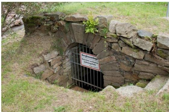
Abbildung 36: Das obere Abzugsrösche Mundloch vom IV. Lichtloch des Rothschnberger Stollns [F.: J. Kugler, 2008]
