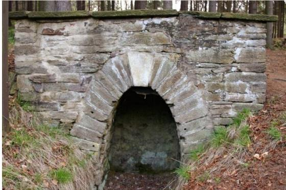
Abbildung 45: Unteres Mundloch der Rösche am V. Lichtloch [F.: J. Kugler, 2004]
