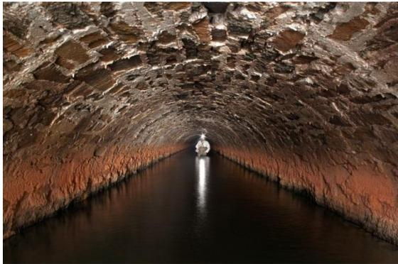
Abbildung 15: Mit Bruchsteinen ausgebaute Rösche des Rothschnöberger Stollns [F.: J. Kugler, 2010]
