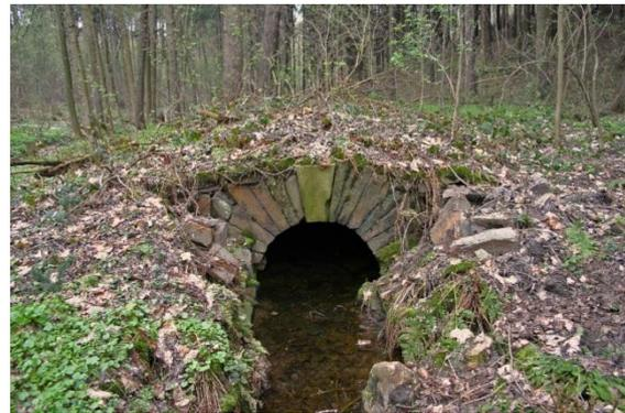
Abbildung 20: Mundloch der Abzugsrösche vom I. Lichtloch [F.: J. Kugler, 2004]
