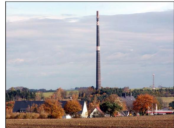
**Abbildung 19: Die Hohe Esse der Hütte Halsbrücke, höchster Ziegelschornstein der Welt, wurde aus Umweltschutzmaßnahmen errichtet.**
