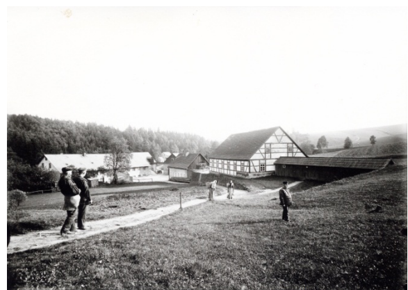
Abbildung 10: Gesamtansicht der Aufbereitungsgebäude vom Häuersteig. Links ist die Stoßherdwäsche sichtbar [F.: Reymann, 1909; Slg.: Kugler]
