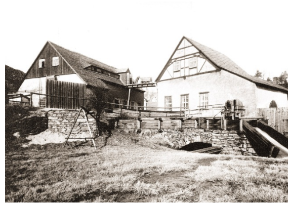
Abbildung 9: Die beiden Pochwerke der Grube mit der gemauerten Aufschlagwasserzuführung [Slg. Kugler; Anfang 20. Jh.]
