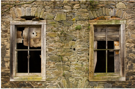
Abbildung 20: Originale Fenster mit gemauerten Stürzen und Holzgewänden [F.: Kugler, 2012]
